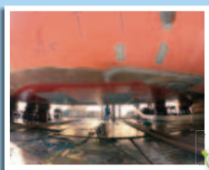
ドックで改修中の白鳳丸②
