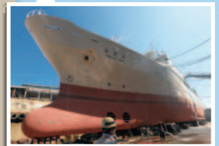
ドックで改修中の白鳳丸①
