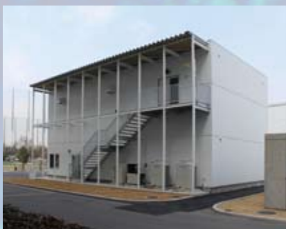
新しく建設された加速器実験棟
