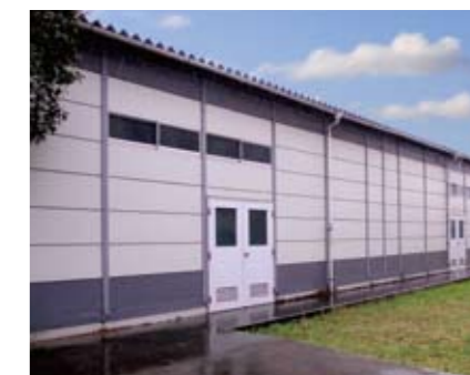
西千葉倉庫の外観
