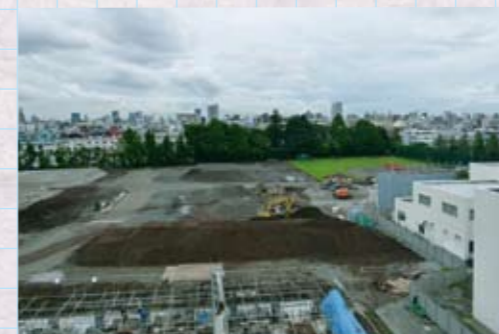
図6 現場状況(2012年9月19日)。取り壊しは概ね終了し、グラウンド整備・新築工事が進んでいる。
