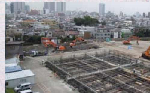
図8 アリーナ棟の基礎工事(2012年10月17日)
