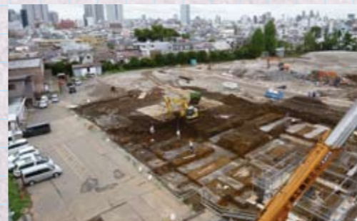
図7 旧海洋研究所A棟取り壊し後の工事状況(2012年9月19日)
