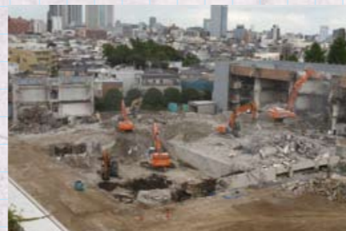
図5 建物の取り壊し作業(2012年8月1日)
