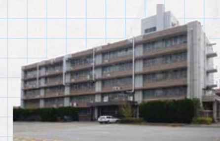
図4 取り壊し前の建物状況(旧海洋研究所A棟正面)
