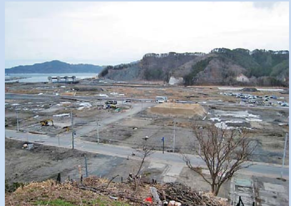
ようやく盛土工事が始まった大槌町方地区
