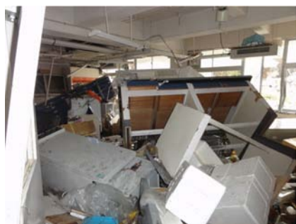
写真8 研究棟2階第2実験室内の様子。津波のために室内の机、機器類がメチャメチャに積み重なっている。
