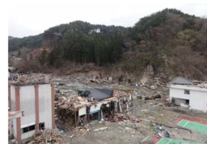
写真5 研究棟屋上から見た船具倉庫（写真中央）と共同利用研究員宿舎（写真右端）。船具倉庫は周囲の壁が流失し、他の民家から流入した瓦礫で埋め尽くされている。船具倉庫の壁の一部は研究棟内の廊下で発見された。共同利用研究員宿舎の屋上には近所の民家の屋根が載っている。
