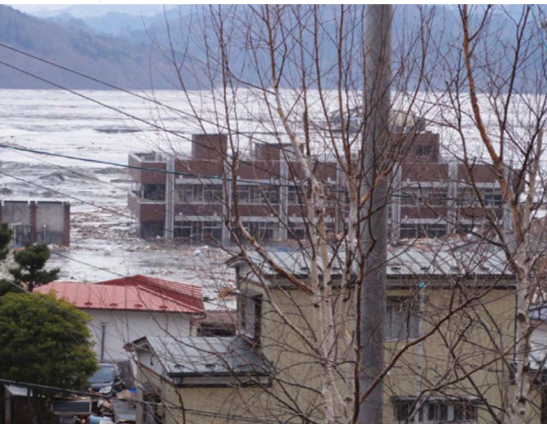
写真3 津波に襲われた沿岸センター。津波第1波は波高が2m程度だったものの第2波、第3波が大きく、津波防波堤を越えて沿岸センター敷地内に押し寄せた。写真は第2波で沿岸センター研究棟（写真中央の濃茶色の建物）2階まで達したところであり、その後さらに水位は上昇して3階窓付近にまで達した。津波第2波で調査船「弥生」は横転、沈没した。
