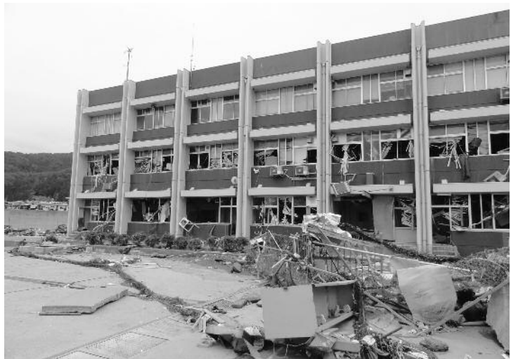
写真8：海側より望む沿岸センター実験棟。一階、二階の窓ガラスは割れているが三階の窓は割れていない。
