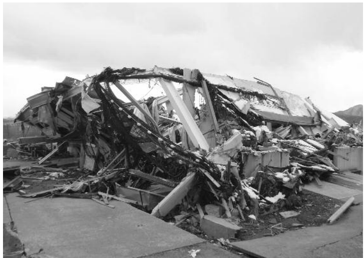
写真6：鉄骨が曲がり、屋根や壁などは完全に破れた上屋。保管されていた観測機器類は流出し、所在不明となった。
