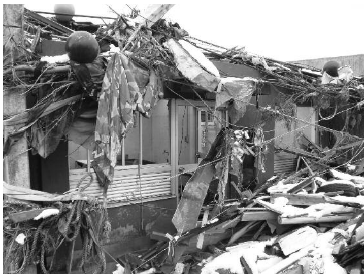
写真14：敷地の外れにあった廃棄物処理室。実験廃液、廃棄予定の試薬類が保管されていたが、窓ガラス、扉のほか、天井までも破れてしまっていた。
