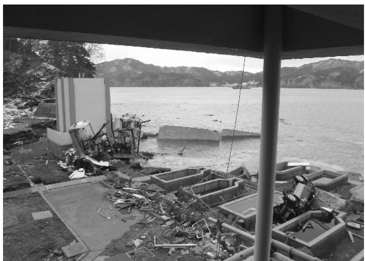
写真7：倒れた津波防波堤と浸食された沿岸センターの敷地。緑色の飼育用の一部は地盤と共に流出した。
