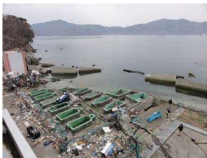
写真6 研究棟屋上から見た屋外コンクリート水槽(写真中央に複数ある緑色の容器)。防波堤が破壊され海側に倒れていることから引き波により破壊されたことが判る。センター敷地の一部が崩れて海水が浸食し、水槽の一部も水没している。
