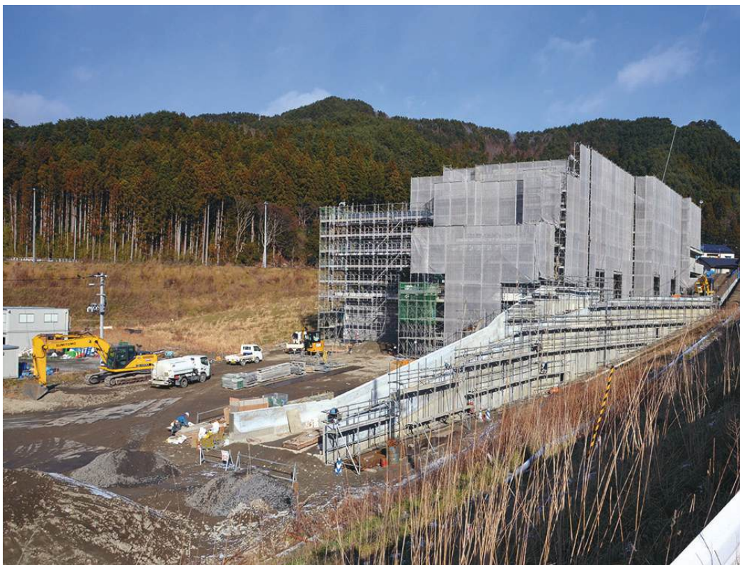
山側の敷地に新しい研究実験棟の建設を開始（2017年12月）
