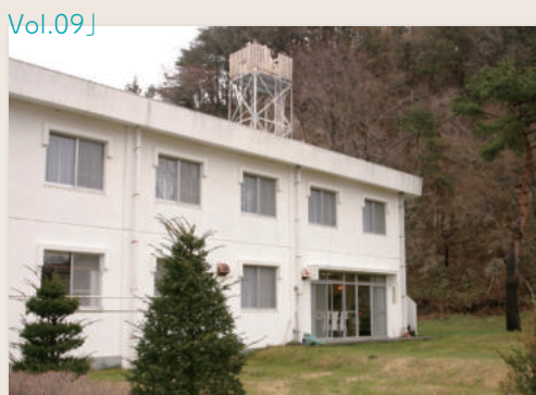
旧沿岸センターの宿泊棟
