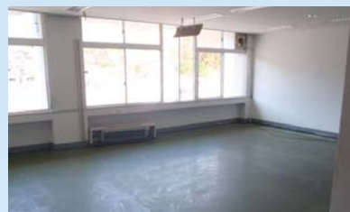
瓦礫の撤去が終了したセンター3階の共同利用研究室。震災直後は什器類が出入口を塞いだ状態だったが、これらは撤去され、清潔な状態に復旧した。割れた窓ガラスも新しいものに交換され、精密機器類の保管も可能になっている。
